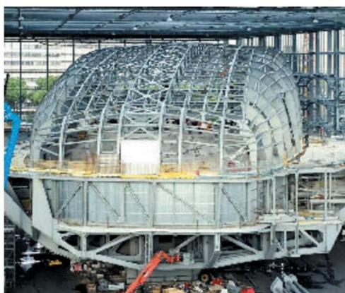
Centro Congressi Il cantiere della Nuvola di Fuksas
